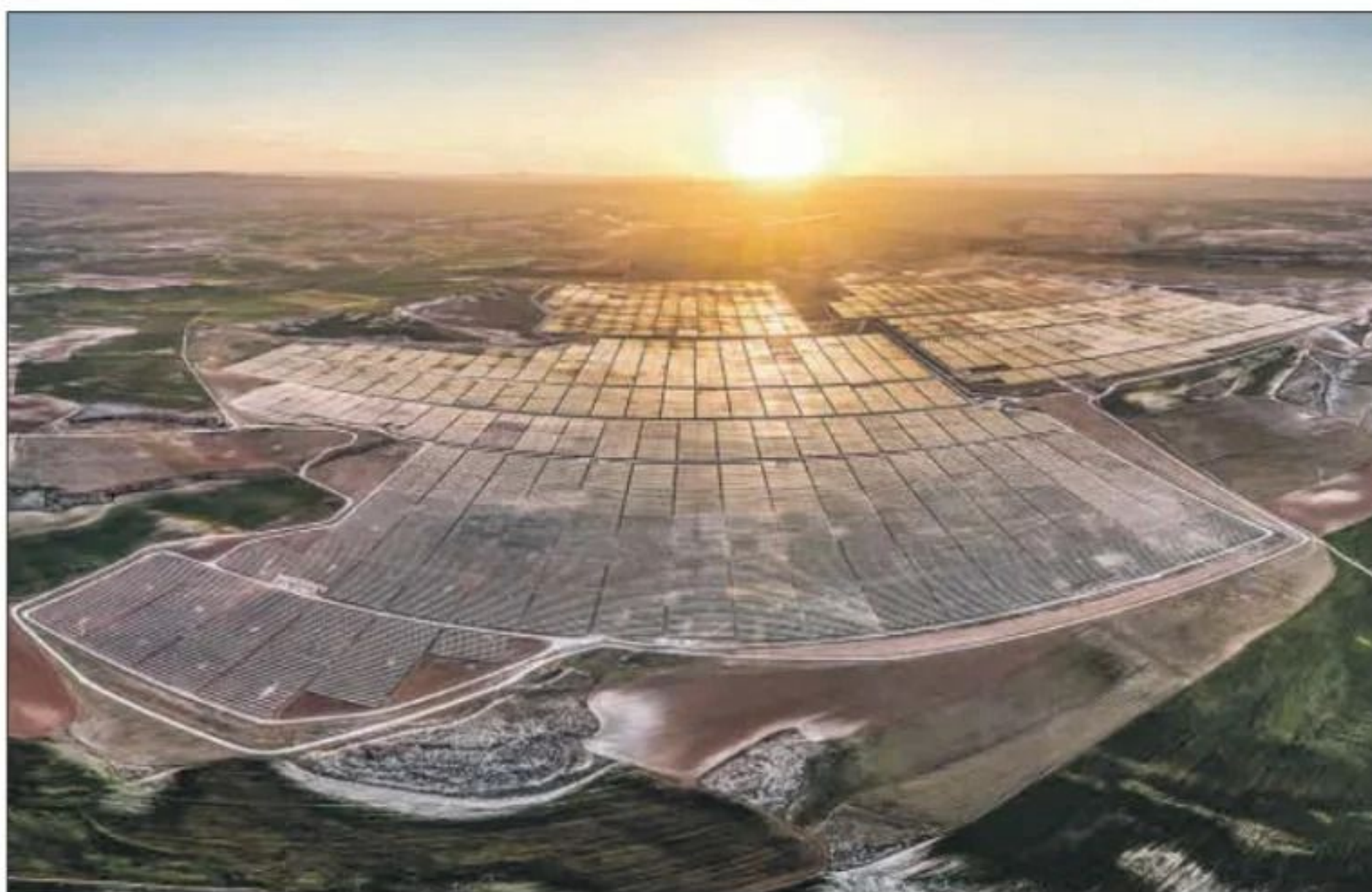
Una planta fotovoltaica en Teruel. EE
